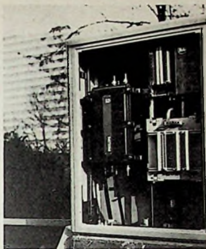
▲ Bild 4 (oben). Verstärker im Kabelschacht
